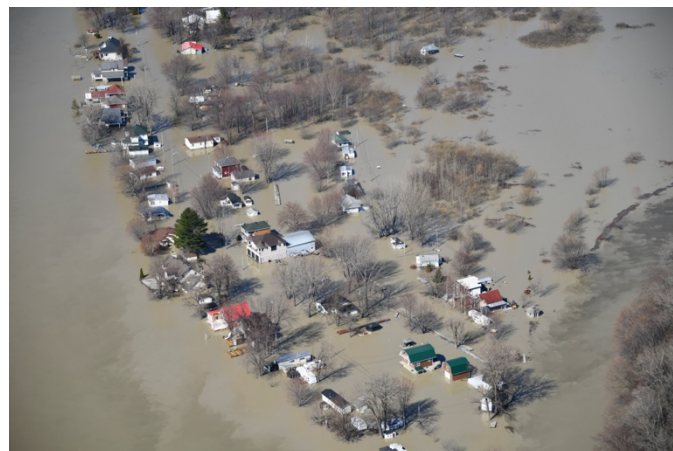
Figure 3. Une portion inondée du centre-ville de Sainte-Marie, en Beauce. Crédit-photo : Pierre Lahoud, 2019.
