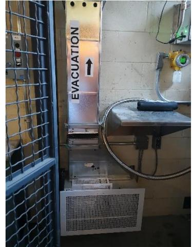
Lors de l'entreposage ou l'utilisation d'azote liquide dans un local, l'utilisateur et le responsable du laboratoire doivent procéder à une évaluation des risques afin de s'assurer que la pièce est suffisamment ventilée pour éviter une baisse du niveau d'oxygène.
