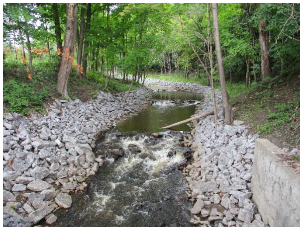
Photos 34 à 36. Section en aval du barrage
