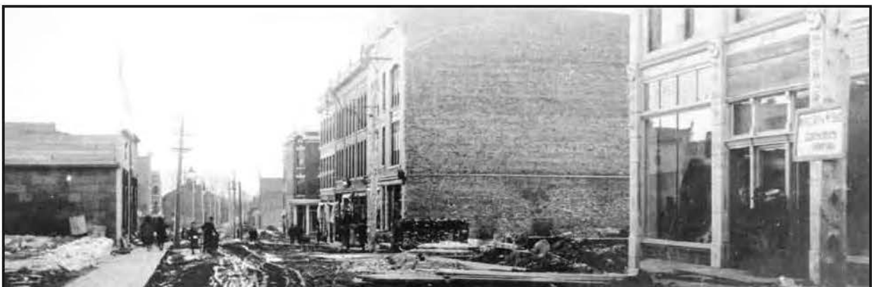
La rue Notre-Dame en reconstruction, vue en direction ouest
