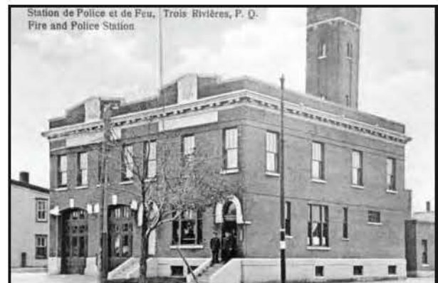
La caserne de pompiers n° 2 vers 1925 Photo: Collection de la SCAP
