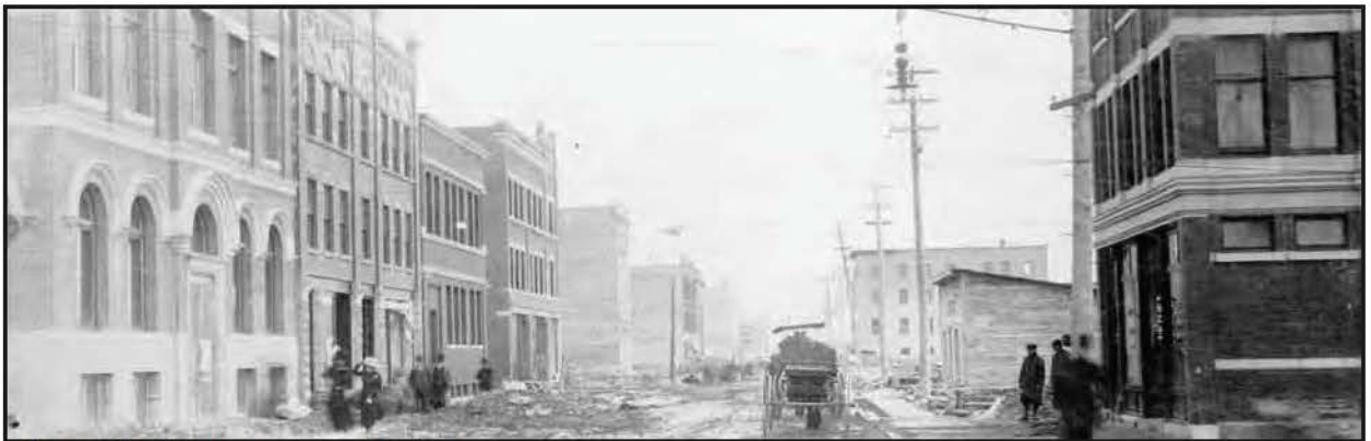
La rue des Forges en reconstruction
