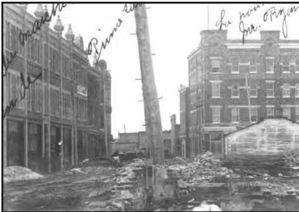
La rue Saint-Antoine, angle Badeaux, en reconstruction À droite: l'hôtel Commercial (plus tard: Saint-Maurice). Photo: Collection de la SCAP
