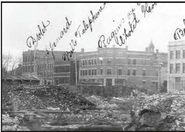
La rue des Forges, angle Hart, en reconstruction Photo: Collection de la SCAP
