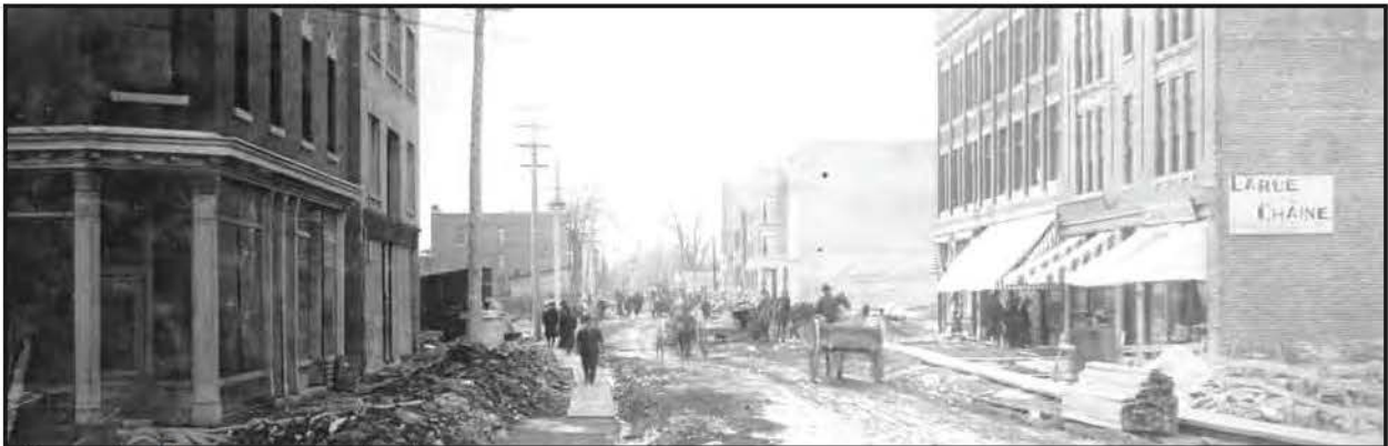
La rue des Forges en reconstruction
