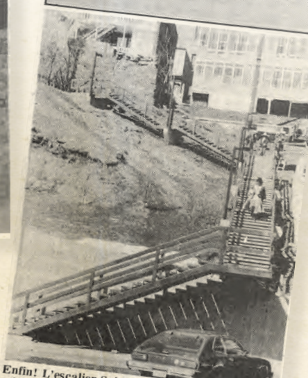
Enfin! L'escalier Saint-Pierre est maintenant terminé. Les gens de la paroisse Saint-Pierre retrouvent leur chemin habituel. En effet, la Ville de Shawinigan a fait la reconstruction de cet escalier dans le cadre du programme particulier urbain (PPU). Le coût de cette construction est d'une somme de 76 645$. (Photo l'HEBDO Léna)
