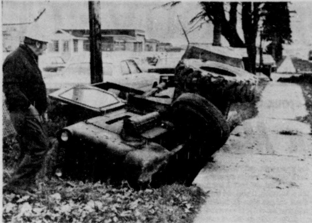
CET ENGIN QUI SERT dans les travaux de construction et de voirie s'est engagé dans un trou profond, à proximité de la Dmtar, hier matin, vers 11 heures. Il
